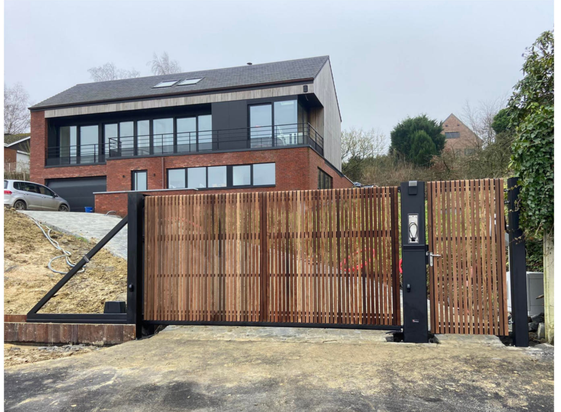
Portail coulissant auto-portant avec habillage en bois
